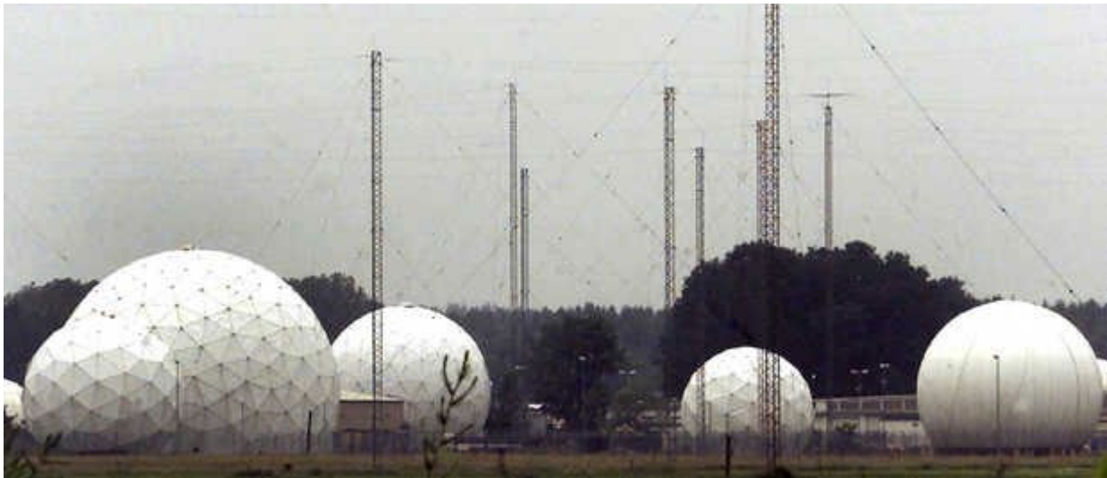
Instalaciones receptoras Red Echelon
